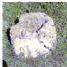
162-163 Pierres creusées qui servaient d'embase aux poteaux en bois jouant le rôle des poinçons d'une charpente.
